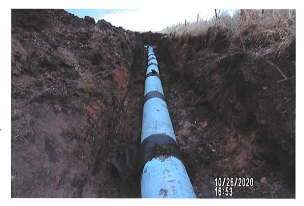
PICTURE# 4719 IS LOOKING EAST SHOWING TILE WITH JOINTS WRAPPED & SITING INTROUGH FROM SPOON BUCKET EAST OF 6PS # 7298
